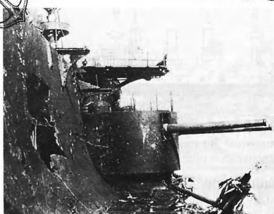
Пробоина от японского фугасного снаряда в борту броненосца "Орел". Подобные пробоины у ватерлинии сыграла роковую роль в судьбе многих русских кораблей при Цусиме...
